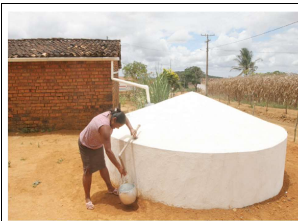
Figura Nº 4: Tipo de cisterna comumente construída na região Nordeste.
